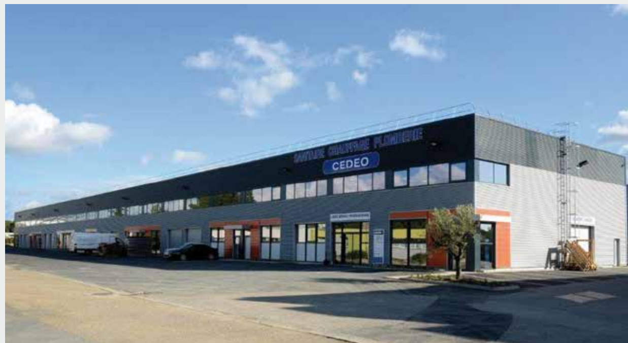
Exemple de réinvestissement : bâtiment implanté sur le parc d'activités du Salaison illustrant la densification en cours
