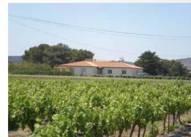
Deux formes de cabanisation à Villeneuve-lès-Maguelone : entre caravanes et constructions illégales
