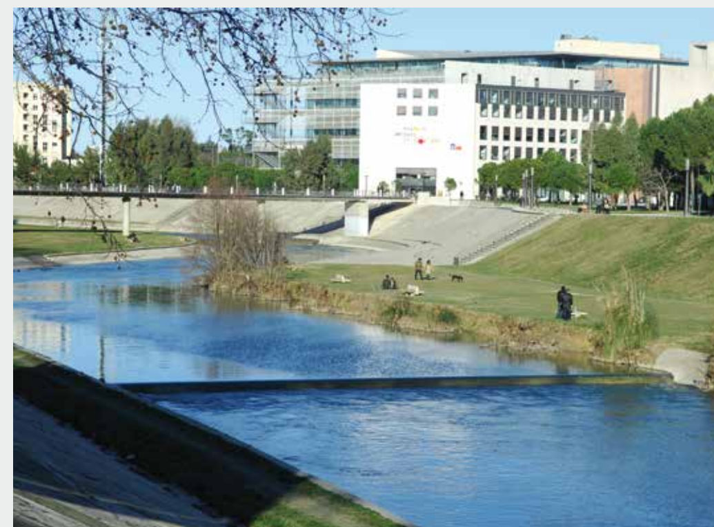
Aménagement du Lez sur la commune de Montpellier
