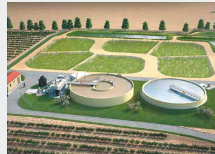
La station d'épuration de Saint-Geniès-des-Mourgues et Sussargues : l'une des six nouvelles stations intégrant des procédés de qualité environnementale
